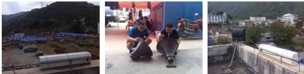
图 12 技术人员安装调试大喇叭和音柱
