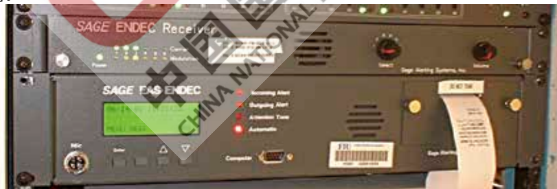
图 12 用来接收和传输预警信息的紧急预警系统（EAS）编解码器（ENDEC）
